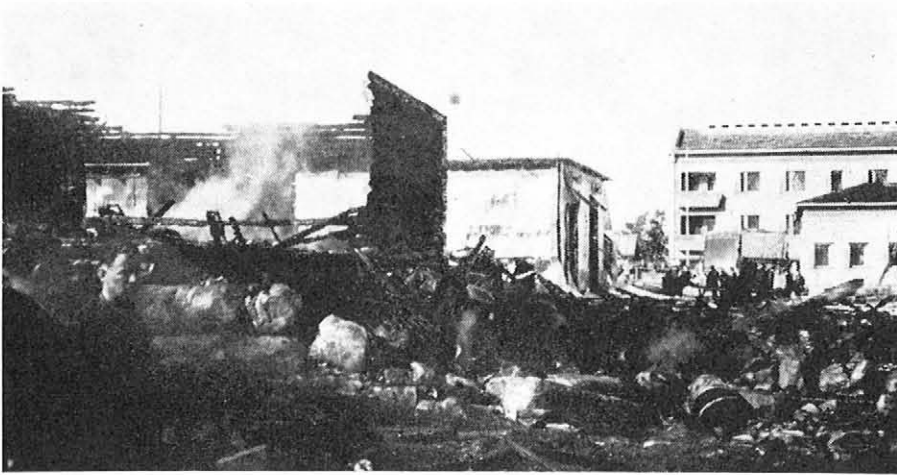
4 PIHANÄKYMÄSSÄ rakennuksen A2 raunnioiden päältä katsottuna on räjähdyspaikka alhaalla oikealla kivikasan edessä. Taustalla nähdään peltiseinäinen rakennustarvikevarasto V7, jonka seinäpinnat aaltoilevat rakennuksen runkoa vasten räjähdyspaineen muotoilemana. V7:n edessä seisova mustunut seinä on varastorakennuksen V5 pääty.
